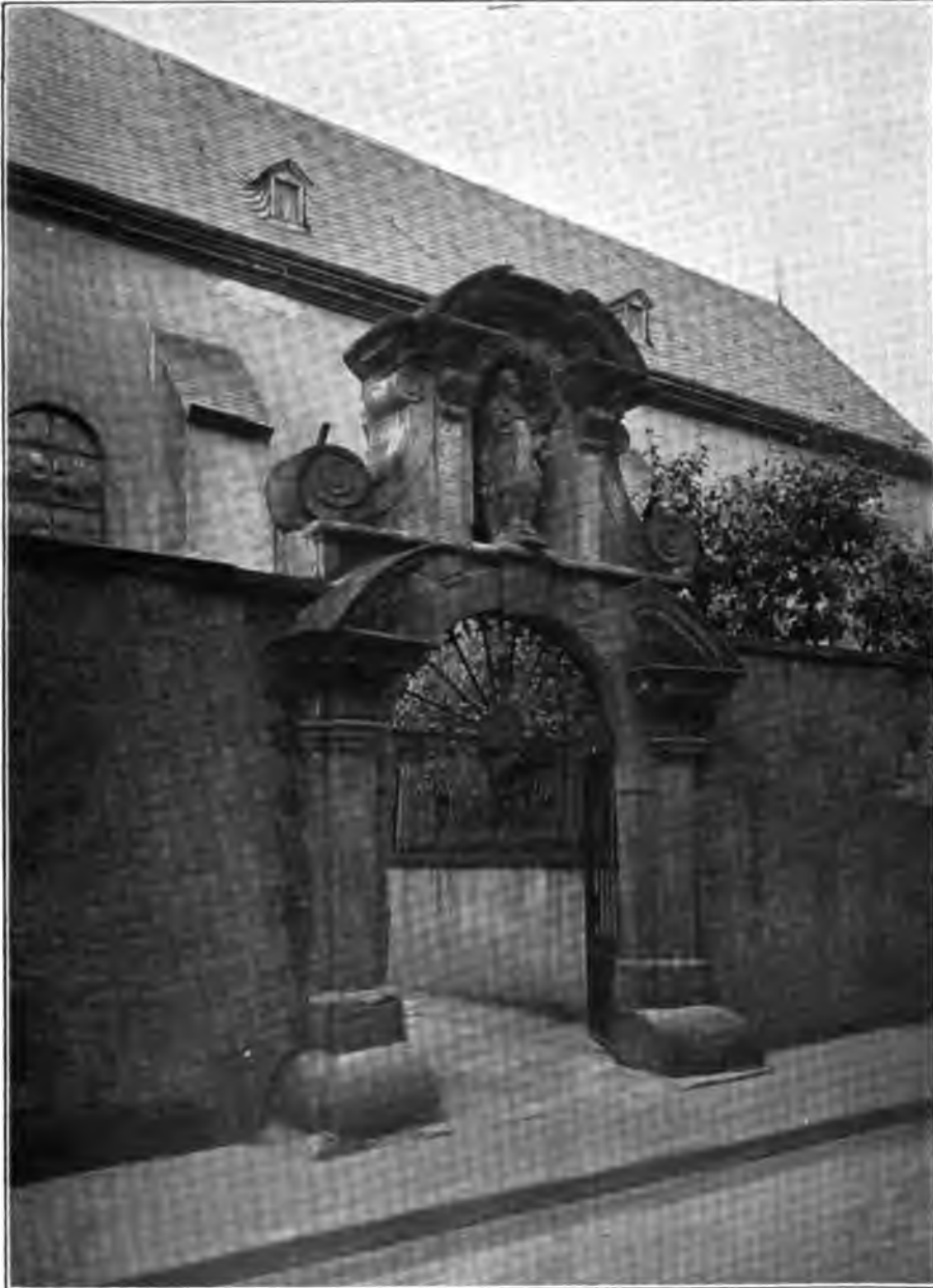
Portal an der Clarissenkirche
